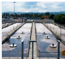
Очистка сточных вод
